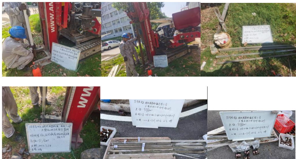
附图四：土壤钻探、取样照片
